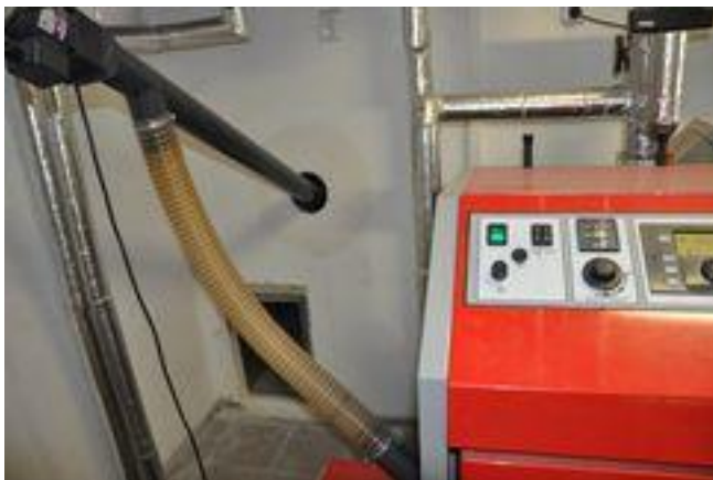
Automatický kotel pro spalování pelet 5. emisní třídy
